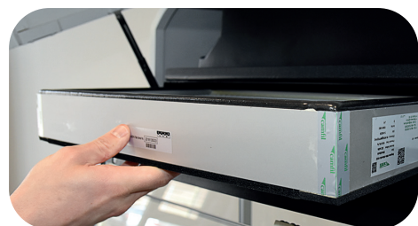
Fig. 49: Retirer le filtre HEPA
